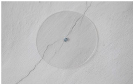
Verschraubung einer flexiblen Plexiglasscheibe zur Sicherung gefährdeter Putzstellen; Foto: H. Haug
